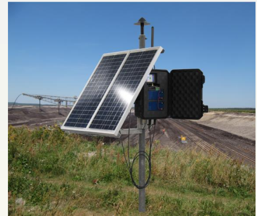
Installation der ersten A07 Monitoring Systeme im Q4 2014
